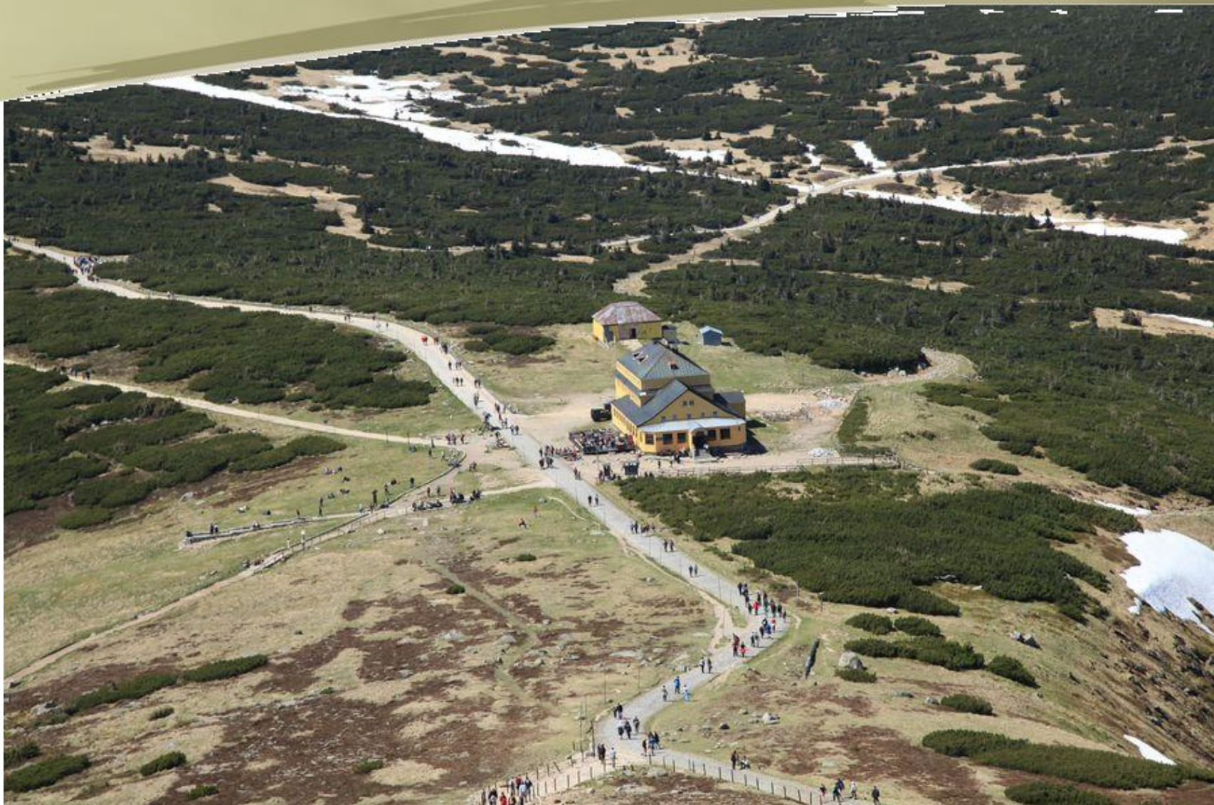
Równia pod Śnieżką
