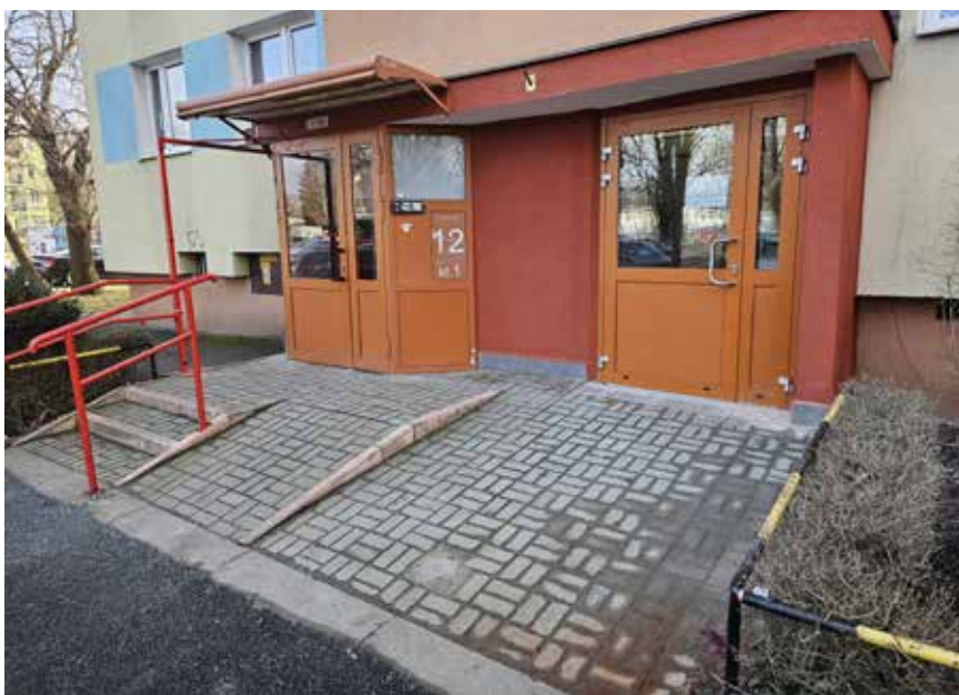
Wjazd do domu bezpośrednio z ulicy, bez żadnych progów ani schodów.
