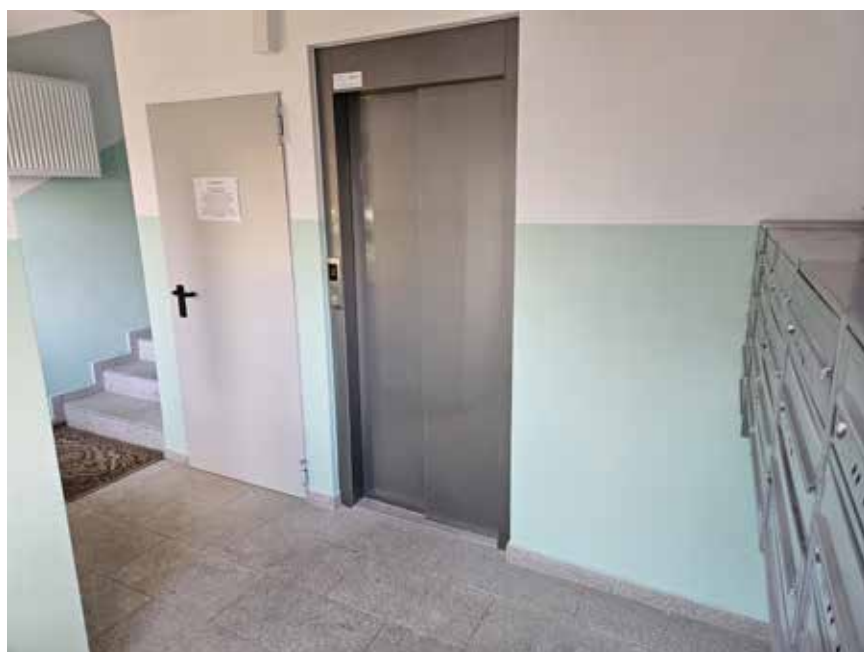
Budynek przy ul. Noskowskiego 10 – jeden z wieżowców, w których Jeleniogórska Spółdzielnia Mieszkaniowa wykonała modernizację polegającą na umożliwieniu wejścia do windy z poziomu ulicy.
