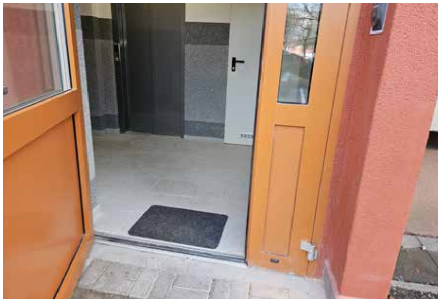
Wejście z poziomu ulicy do domu i od razu do windy w bloku przy ul. Różycyńskiego 12 na osiedlu Zabobrze w Jeleniej Górze.
